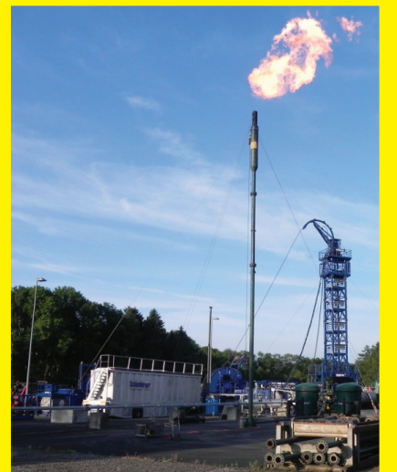
Wartungsarbeiten auf Erdgasförderplatz. Nicht verwertbares Erdgas wird abgefackelt.
