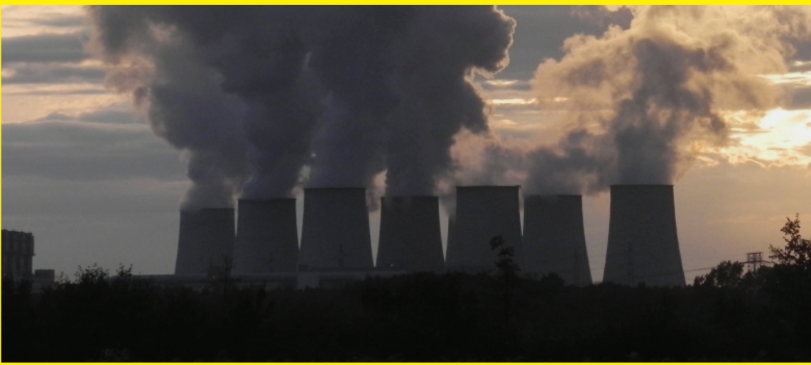
Wasserdampf aus den Kühltürmen des Braunkohle-Kraftwerks Jänschwalde – Kohlendioxid ist unsichtbar
